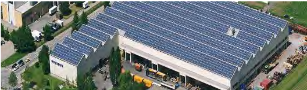
Ενσωμάτωση φωτοβολταϊκών σε βιομηχανική στέγη
