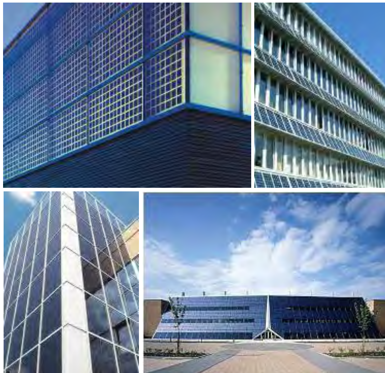
Εφαρμογές φωτοβολταϊκών σε προσόψεις κτιρίων
