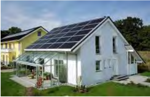
Ενσωμάτωση φωτοβολταϊκών σε στέγες κτιρίων
