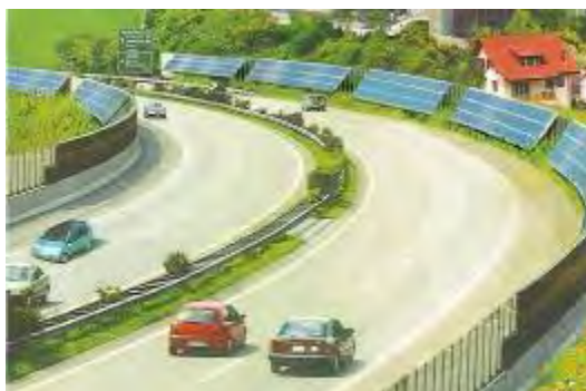
Εφαρμογή φωτοβολταϊκών σε ρόλο ηχοφράγματος σε αυτοκινητοδρόμους
