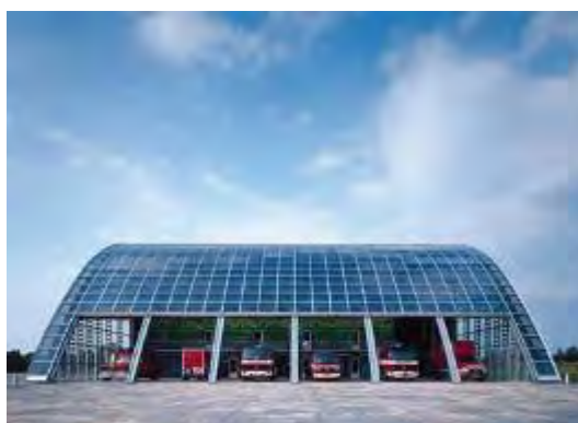
Ενσωμάτωση φωτοβολταϊκών σε πυροσβεστικό σταθμό
