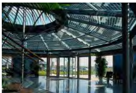
Εφαρμογή φωτοβολταϊκών που επιτρέπουν τη διέλευση φυσικού φωτός σε εμπορικό κτίριο
